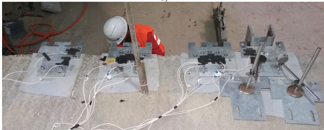
Рис. 4. Процесс испытания существующего кронштейна светопрозрачных фасадов: а – индикаторы часового типа для измерения перемещений анкерной группы, б – тензорезисторы для снятия показаний напряжений, в – общий вид сверху испытываемых кронштейнов в количестве 4 шт. (иллюстрация авторов)
